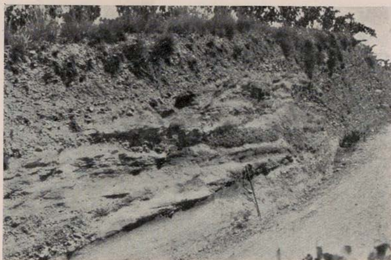
Fig. 1. Desmónte en la carretera de Olesa, a la entrada de pueblo, que corta la terraza de 120 metros.
