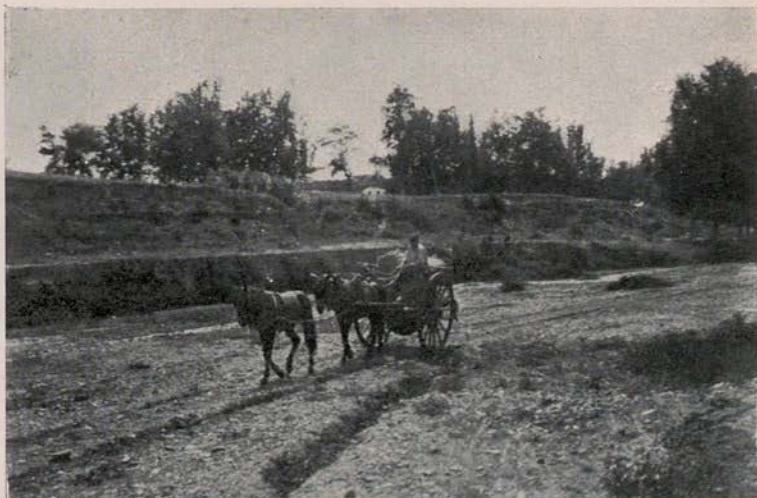
Fig. 2 Lecho mayor y las dos terrazas inferiores de la riera de Rubí a unos 200 metros aguas abajo de la estación del ferrocarril.
